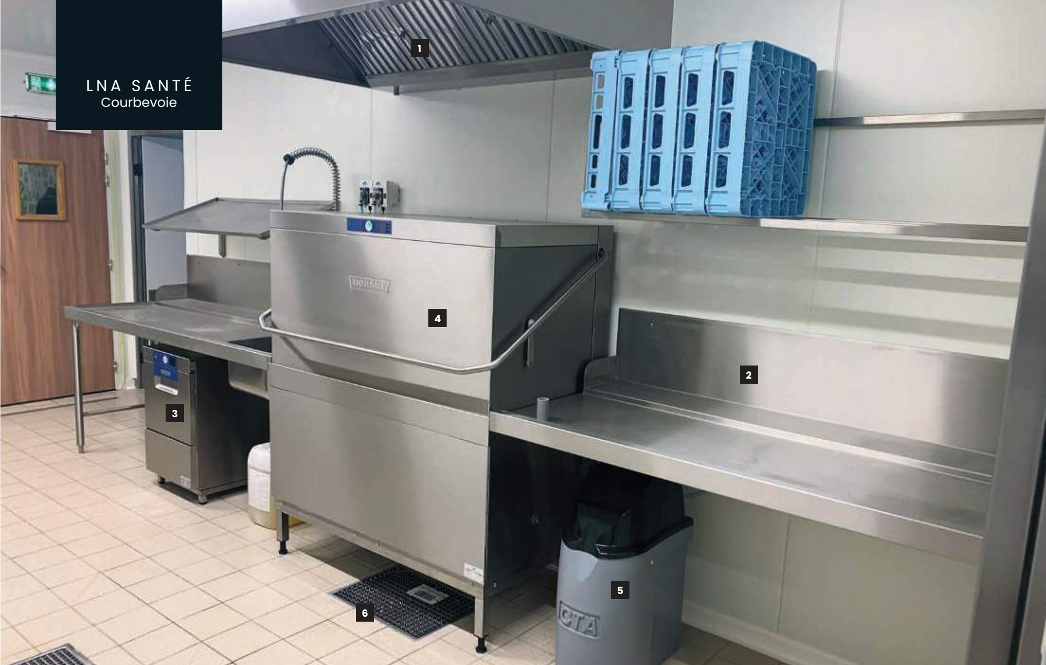
1 Hotte VMI 2 Inox sur mesure BÉNARD INOX 3 Lave verres frontal HOBART 4 Lave-vaisselle double capot HOBART 5 Adoucisseur eau froide CTA 6 Caniveau de sol ACO
