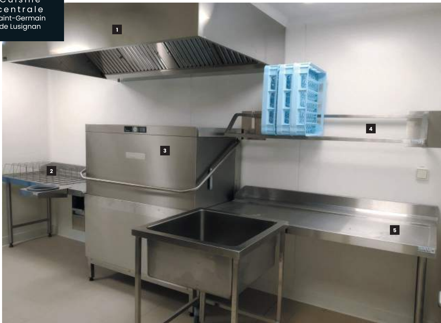
1 Hotte VIM 2 Table d'entrée TOURNUS 3 Lave-vaisselle à capot twin Premax HOBART 4 Etagère TOURNUS 5 Table de sortie TOURNUS
