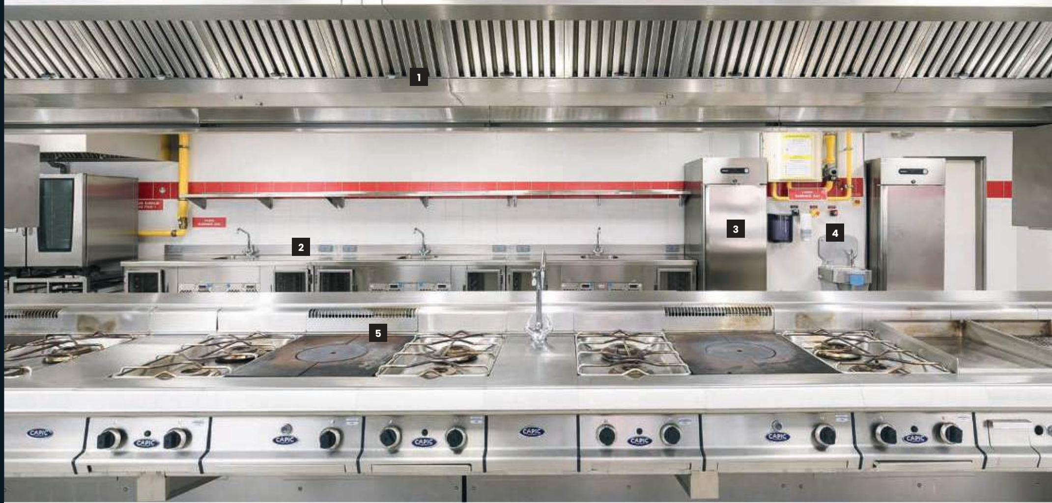
1 Plafond filtrant SAFTAIR 2 Plan de travail PYRENOX 3 Armoire réfrigérée HOSHIZAKI (x2) 4 Lave-mains TOURNUS 5 Ensemble cuisson avec feux vifs et plaques coup de feu CAPIC
